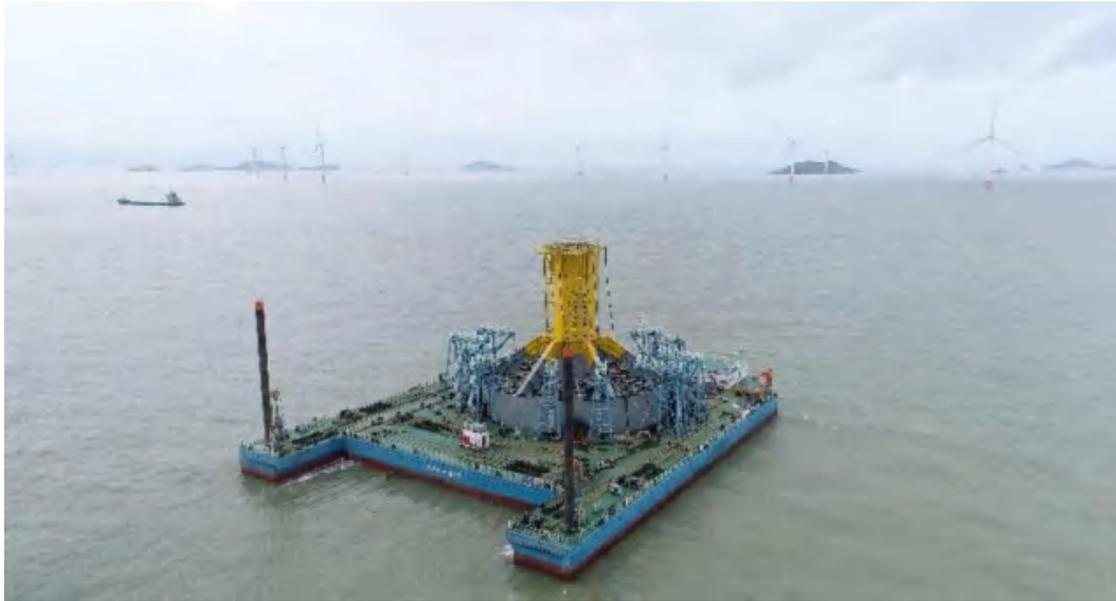
图 2.3.1-6 浮运平台基础示意图
