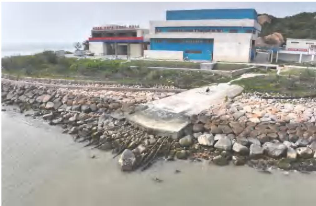
图 2.1.2-2 一期工程及本项目三角岛南侧海缆登陆段建设现状图（2024 年）
