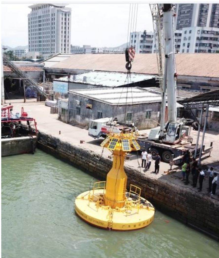
图 2.3.1-1 浮标吊装下水工作图
