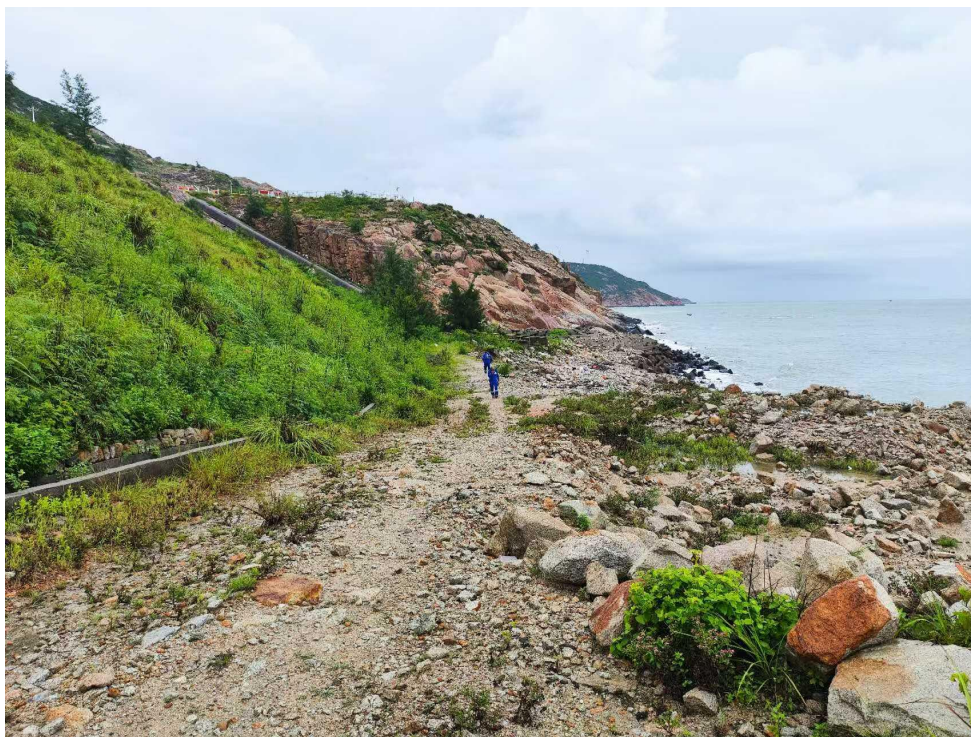
图 2.3.2-3 临时便道未建成现状
