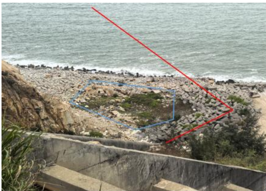
图 2.2.3-1 临时堆场旧状（红色标线为海管路由，蓝色范围为材料堆场区域）
