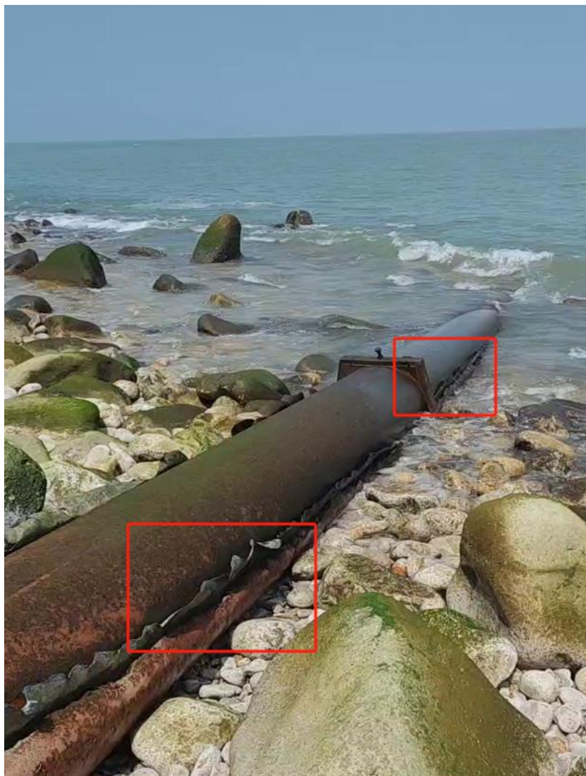
图 2.1.5-1 海管上登陆段外保护层破损裸露照片
